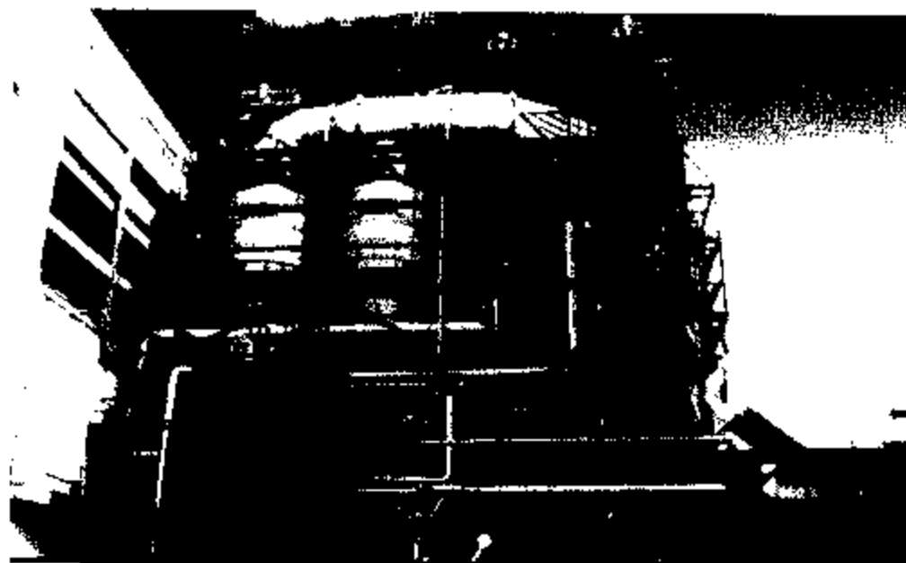
图1-10 哈尔滨锅炉厂有限责任公司300MW 循环流化床锅炉 (主蒸汽流量1025 t/h; 主蒸汽压力17.5 MPa; 再热蒸汽流量846 t/h; 主蒸汽和再热蒸汽出口温度540℃; 给水温度281℃)
